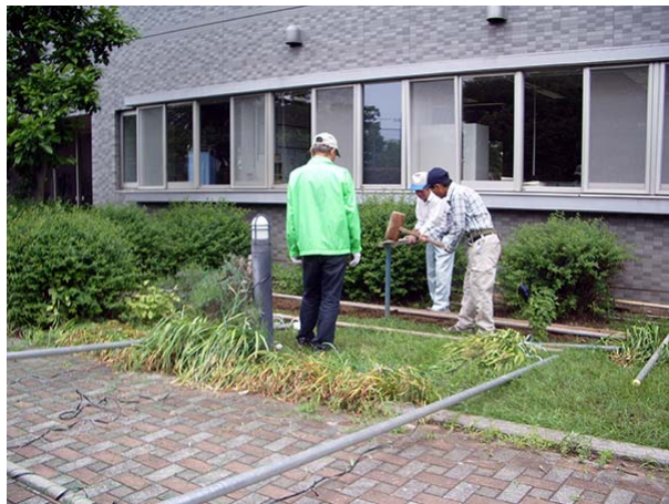
2. 「緑のカーテン」を支えるフェンスの支柱を念入りに、気合を入れて打ち込みました。
