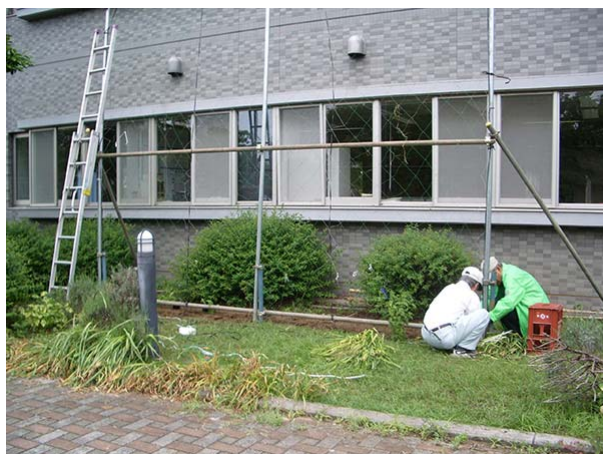
5. フェンスにネットをピンと張り付けます。ラダー（梯子）に登り、上部の調整もしました。
