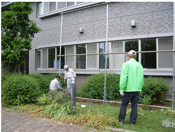
3. 写真ではフェンスが立っていますが、実は立ち上げが1番の難所。写真を撮る暇がありません。
