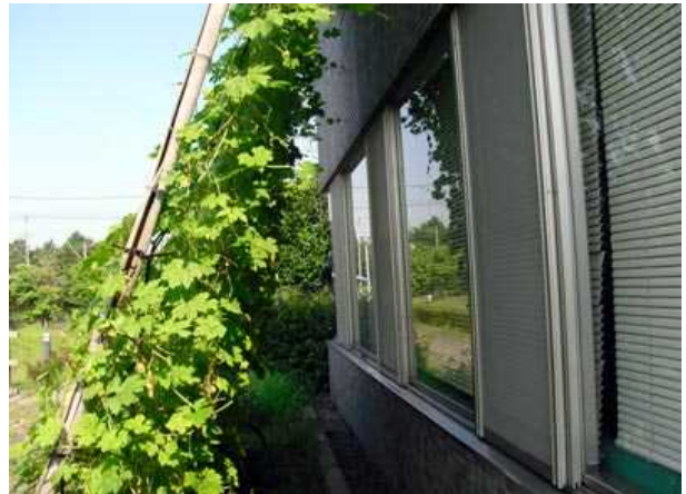
吉川市北部市民サービスセンター／旭地区センター
